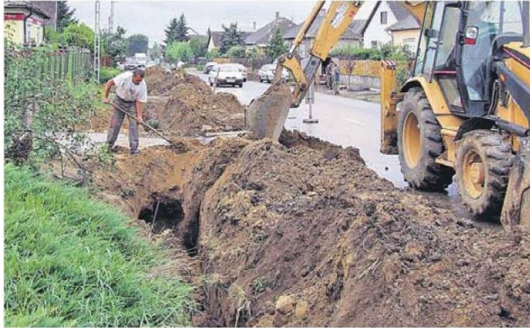
A főút mellett is kicserélték a vízvezetékeket Kállósemjénben
